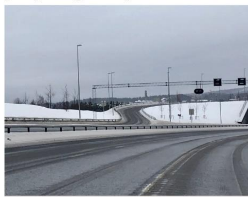
FEIL, DOKSERT: Lastebilsjåfører sliter med påkjøringsrampe fra Gran sentrum og sørover på riksveg 4 oppleves som utfordrende. Foto: Sissel Skjerve/avn Rjeinkolagen
